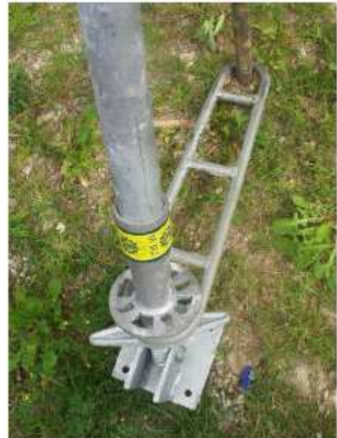
Zajištění patek stojky kolíkem do země. Obr. III / 10
