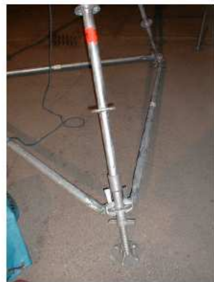
Alternativní zajištění stojek diagonálami ze sad 2-4. Obr. III / 4
