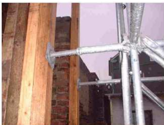
Hotová stěnová opěra s patkovým adaptérem (Obr. V / 18)
