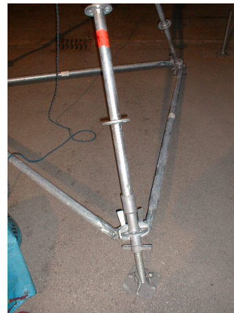
Alternative Abspannung mit Diagonalen aus den Bausätzen 2-4. Abb. III / 4
