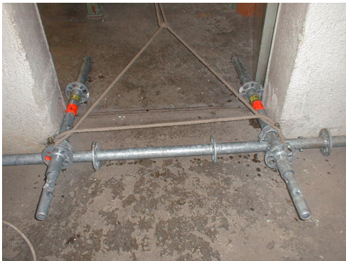
Türquerriegel hinter einem Türrahmen verankert. Die Vertikalstiele 1,0 m verhindern das seitliche Verrutschen des Vertikalstieles 2,0 m. (Abb. III / 27)
