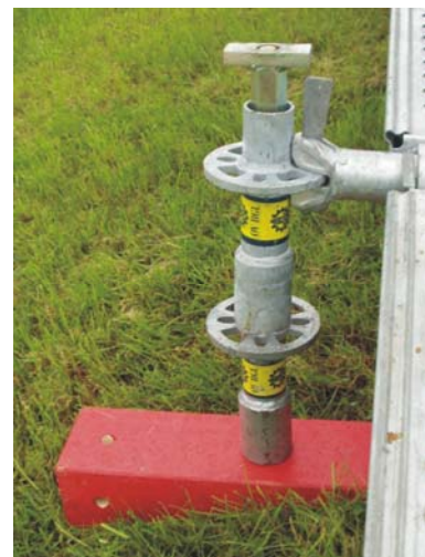
Anfangsstücke als Höhenausgleich mit Holzunterbau Abb. VI / 41
