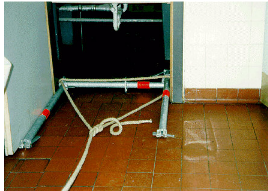
Türquerriegel aus Richtung der Fensteröffnung aufgenommen, mit Sicherheitsseil zur Aufnahme eines Auf-/Ablassgerätes. (Abb. III / 28)
