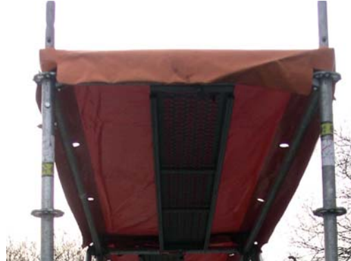
Einbau der Bodenbeläge Abb. VII / 39
