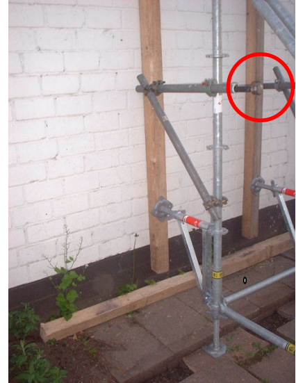
Beispiel einer Aufgleitsicherung mit Gerüstrohren und Erdnägeln (Abb. V / 17)
