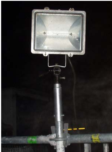
Auf Vertikalstiel befestigter Scheinwerfer Abb. IV / 33
