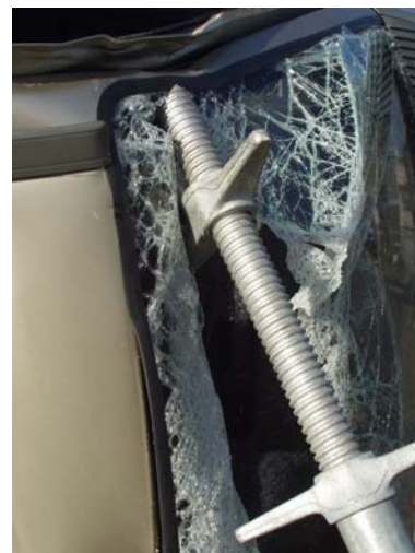
An Holmen kann die Klaue der Gewindestange eingesetzt werden. Abb. IV / 28
