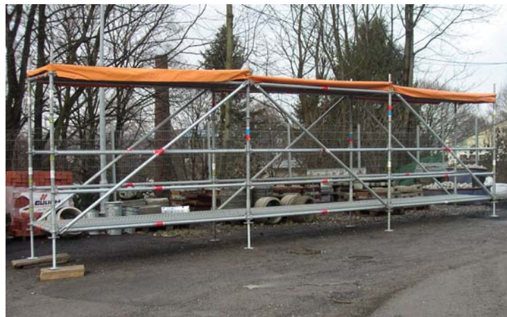
Überdachter Steg Abb. VII / 37
