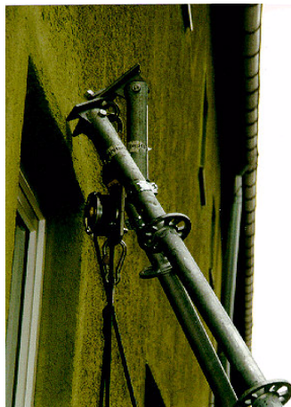
Lastarm an einer Hauswand angelehnt mit angeschlagenem Rollgliss-Gerät. (Abb. III / 10)
