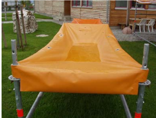
Wassersack nach Starkregen bei fehlendem Einbau eines Bodenbelags Abb. VII / 38
