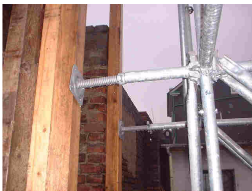
Fertiger Wandanschluss mit Fußplattenadapter (Abb. V / 18)
