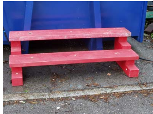
Zweistufige Treppe aus Stufenklötzen und Bohlen mit Schnellschrauben fixiert. Abb. A / 14
