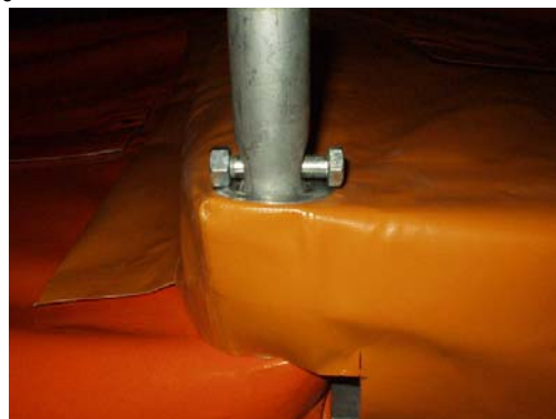
Sicherung der Deckelplanen Abb. VII / 40
