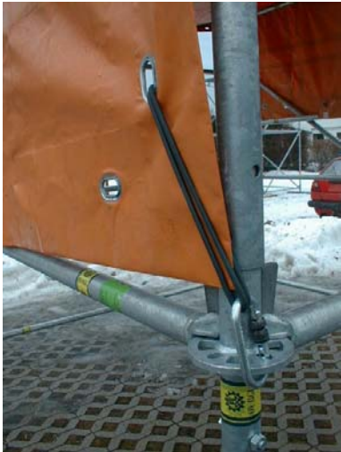
Eckenfixierung mit Gummiring und Karabiner Abb. VII / 32
