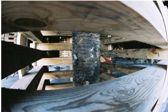
Um eine geschwächte Struktur herum errichteter Kreuzstapel [Pentagon, FEMA] Abb. A / 17
