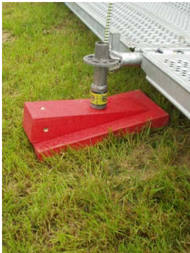
Verankerung am Hang. Zum Höhenausgleich wurde das Anfangsstück kopfüber eingesetzt, zum Neigungsausgleich der Rüstholzteile.
