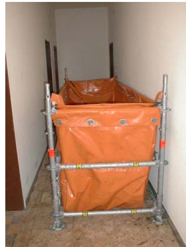
Faltbehälter in beengten Verhältnissen aufgebaut
