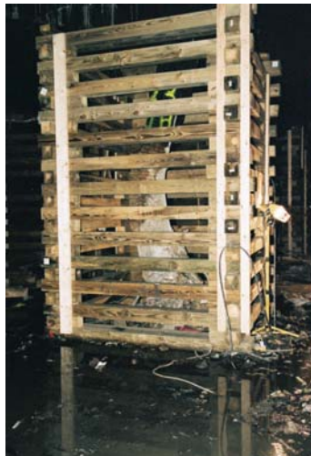
Kreuzstapel mit Brettersicherung (Pentagon, FEMA). Abb. A / 27
