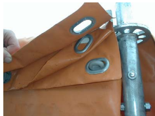
Im Bereich der Dreifachüberlappung wird stets die unterste und die oberste Planenschicht in die Knebel eingebunden. Abb. VII / 13
