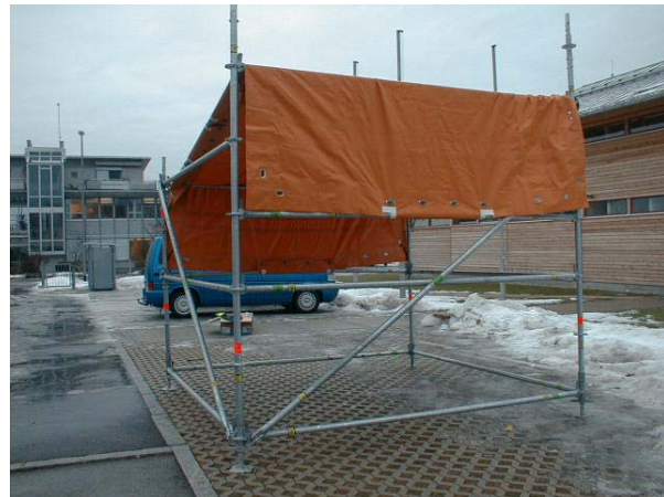
Überdachung 3 x 3 m Abb. VII / 42
