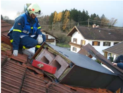
Abgebrochener Kamin, mit Hilfe der inneren Verspannung durch Ankerstäbe...
