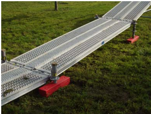
Übergang Schnellsteg zu Trümmersteg.
