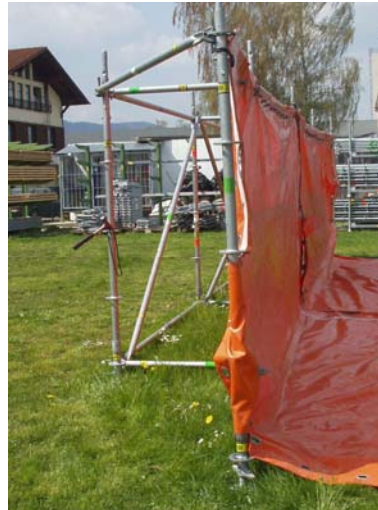
MZP-Fixierung an Vertikalstiel Abb. VII / 33
