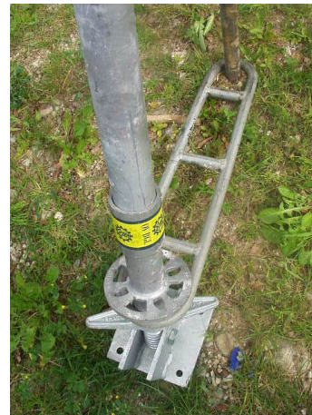
Fußpunktsicherung eines Bockbeines mit Erdnägeln. (Abb. III / 11)
