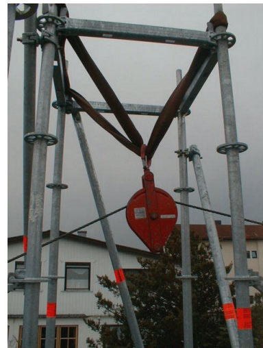
Einhängevariante mit kürzerer Nylonrundschnur Abb. VI / 37
