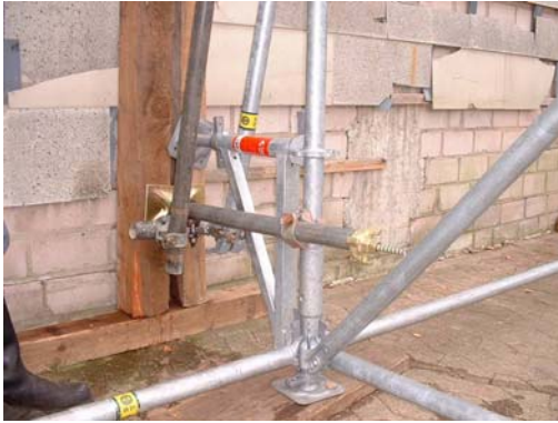
Aussenseite der Abstützung (Abb. A / 57)
