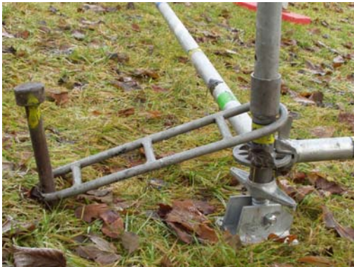
Alternative Sicherung mit Anschlagstück. Abb. VII / 26
