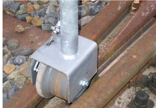
Festsitzende Gleisrolle im Herzstück einer Schiene (vermeidbar) (Abb. VIII / 9)
