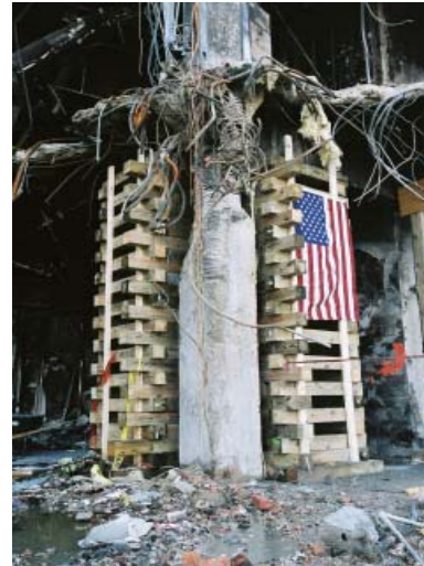
Die Kreuzstapelmethode eignet sich zur Ableitung schwerster Kräfte [Pentagon, FEMA]. Abb. A / 18
