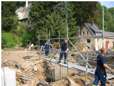
Der Hochwasserlaufsteg kann ebenso als Trümmersteg eingesetzt werden. Abb. VI / 19a
