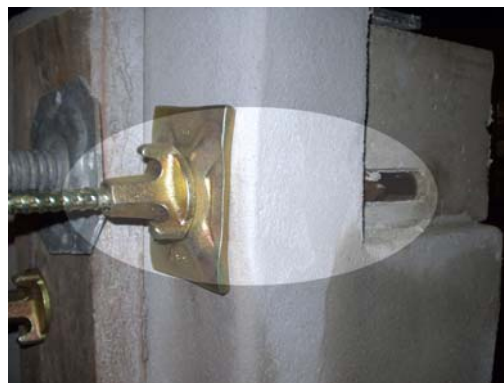
Demonstrationsanker mit Sichtbohrung.
