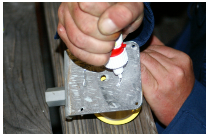
Das Fluid wird auf die Grundplatte aufgetragen (Abb. II / 21)
