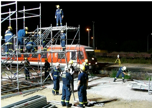
Einmessung einer EGS-Brücke (Abb. IV / 1)
