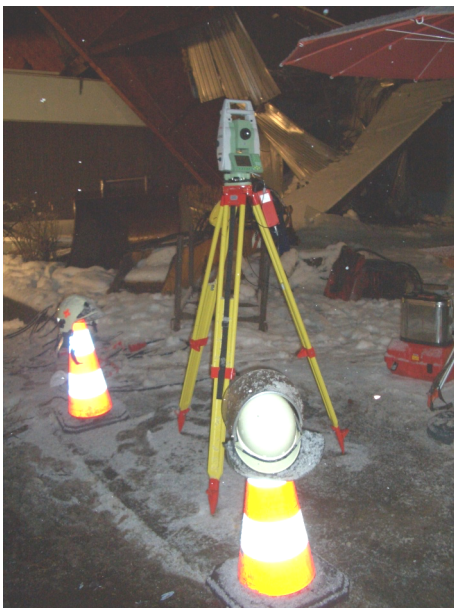
Absicherung mit Leitkegel (Abb. II / 1)
