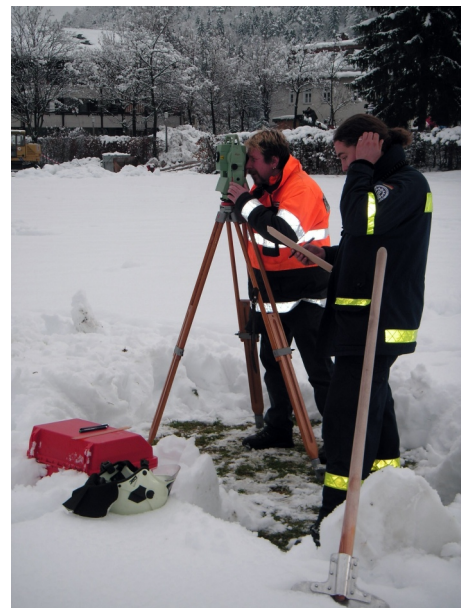
Freigeschaufelter Untergrund (Abb. II / 2)
