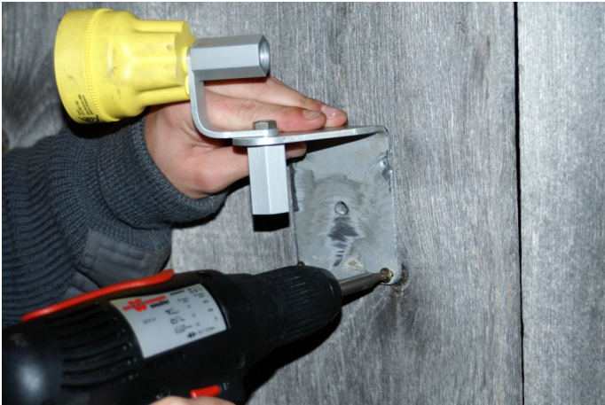
Befestigung eines Prismas mit Schrauben an einer Holzwand (Abb. II / 26)
